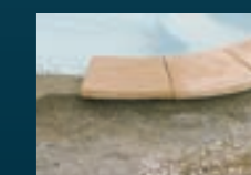
POSE DES MARGELLES
